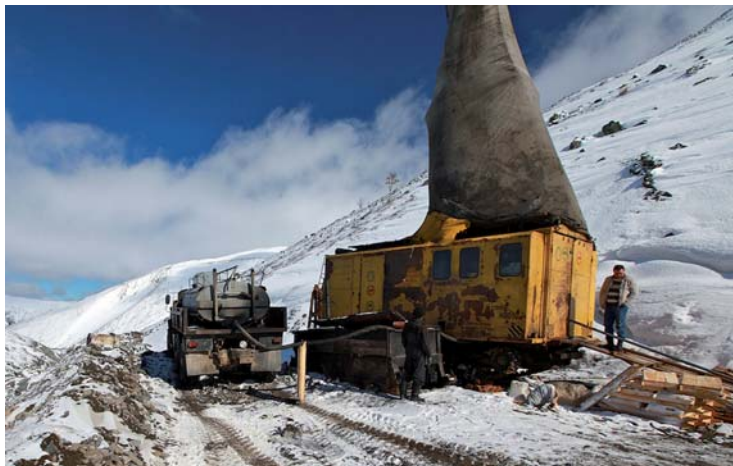
Буровые работы на Удоканском месторождении. Источник фото: официальный Интернет-сайт ООО ББК ( http://www.bgk-udokan.ru )
